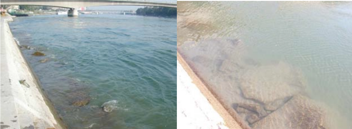
Abb. 1: Strecke 1F am St. Johann-Rheinweg (links) mit Detailaufnahme der Blöcke, die als Aufwertung unter der Niederwasserlinie eingebracht wurden (rechts).
