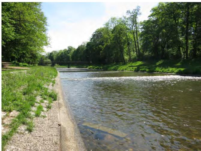
**Abbildung 15:** Strukturloser gleichförmiger Böschungsfuss der Wiese, der bei höheren Abflüssen keine geeigneten Refugien bietet, um das Abschwemmen der Fische zu verhindern.
