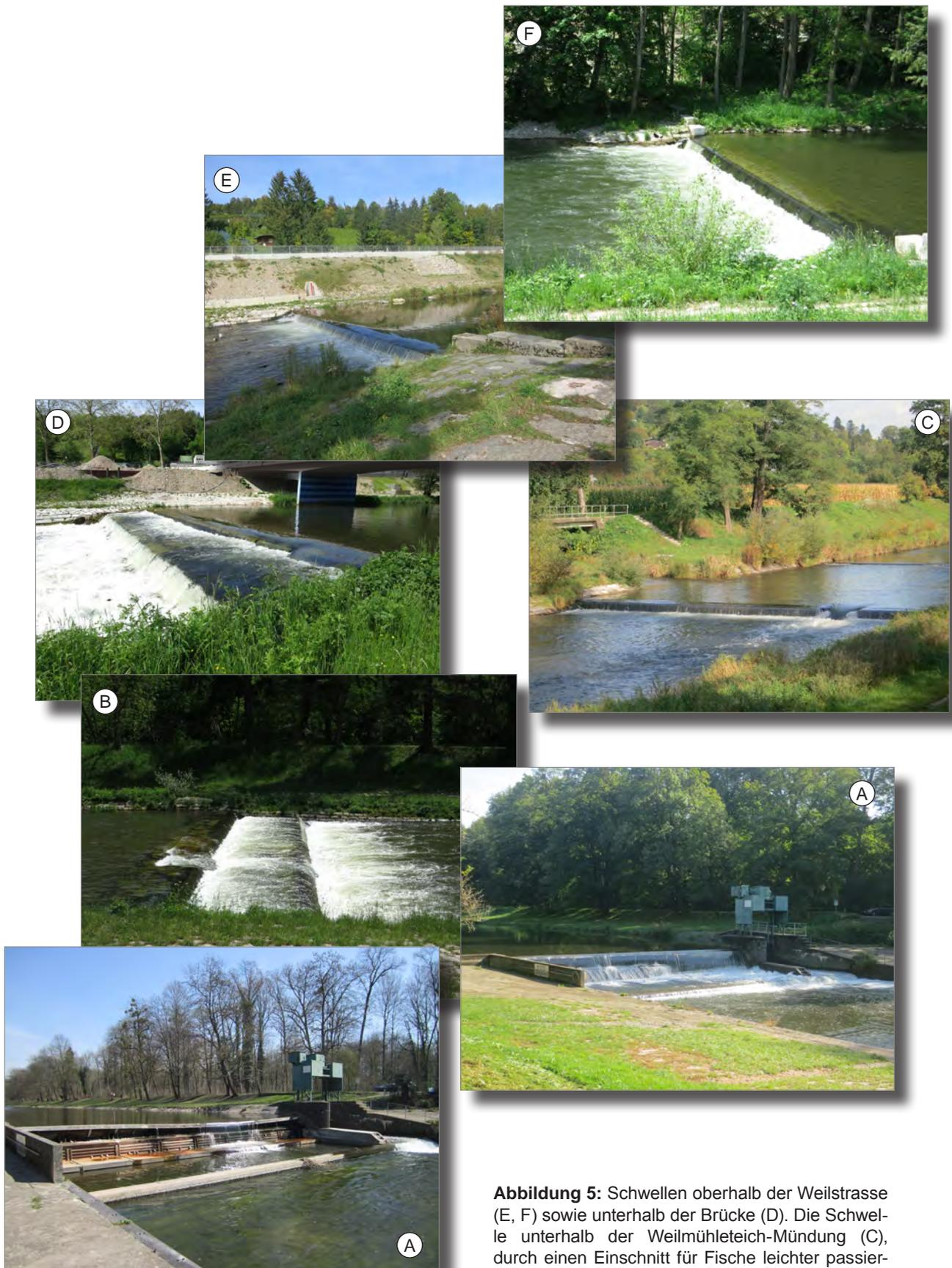
**Abbildung 5:** Schwellen oberhalb der Weilstrasse (E, F) sowie unterhalb der Brücke (D). Die Schwelle unterhalb der Weilmühleteich-Mündung (C), durch einen Einschnitt für Fische leichter passierbar. Doppelschwelle unterhalb des Erlenstegs (B). Schliesse-Wehr (A). Position vgl. Abbildung 4.
