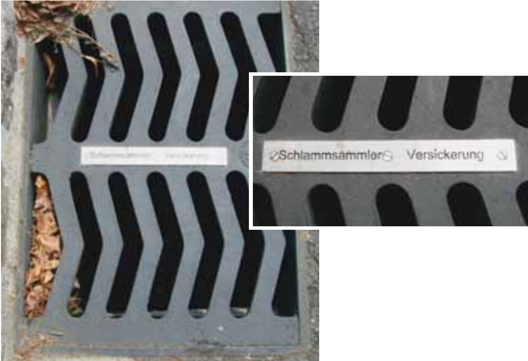
Bild 5: Beschriftungsbeispiel eines Einlaufschachts
