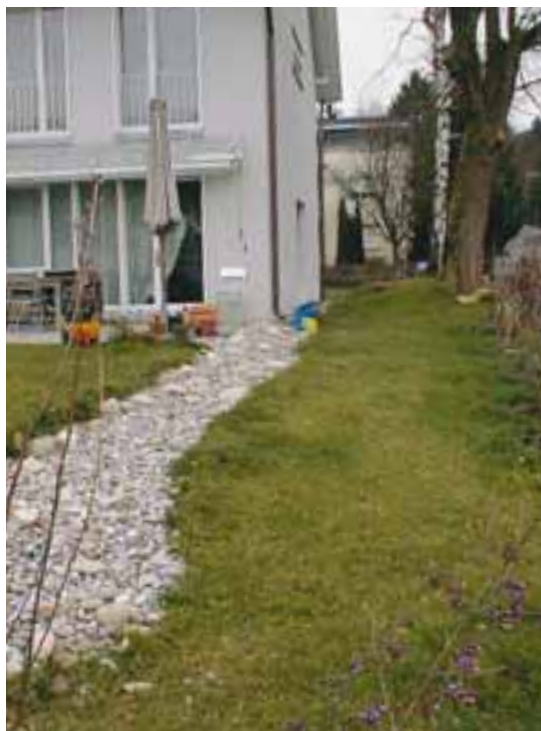
Bild 3: Sickergraben
