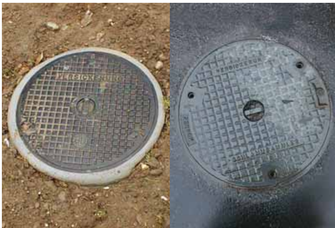
Bild 4: Beschriftungsbeispiel Versickerungsschacht und Schlammsammler
