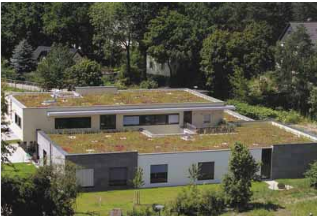
Bild 6: Beispiel für eine Dachbegrünung
