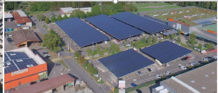
: Auf dem Lac de Toules wurde die erste schwimmende PV-Anlage der Schweiz Abbildung 8: Mit dem «Solarparkplatz» deckt die Migros im Einkaufszentrum Chablais in Aigle rund die Hälfte ihres Stromverbrauchs. Die Eigenverbrauchsquote liegt bei 70% (Bild: © Romande Energie).
