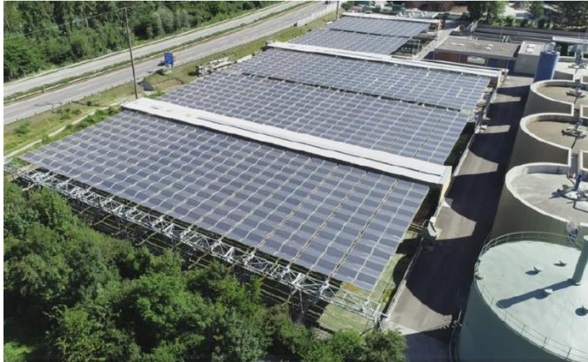
5: In der ARA Chur wurden die Klärbecken mit einer einfahrbaren Fold-PV-Anlage überdeckt (Bild: © dhp).
