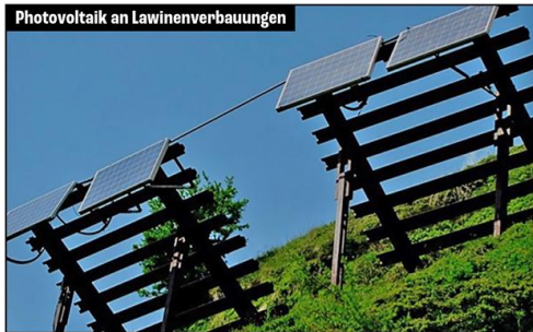
Quelle: Ruedi Lehmann/ ee-News Solarmodule mit steiler Ausrichtung an Lawinenverbauungen könnten sehr viel Winterstrom liefern. An hochalpinen Lagen führt dies zu erhöhten Installations- und Netzanschlusskosten.
