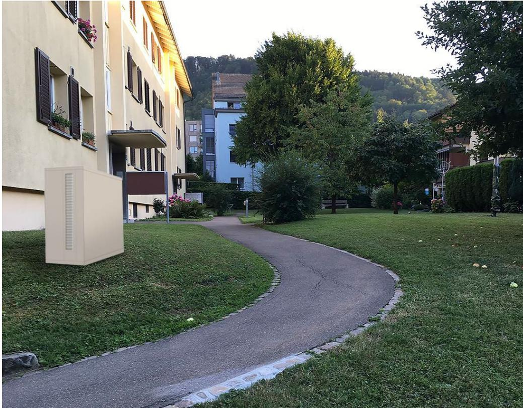
**Abbildung 76: Grosse Luft/Wasser-Wärmepumpe farblich angeglichen an Fas sade.**
