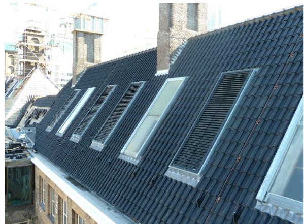
**Abbildung 58: Beispiel für Luftgitter in Dachfläche. Quelle: Smitsair**
