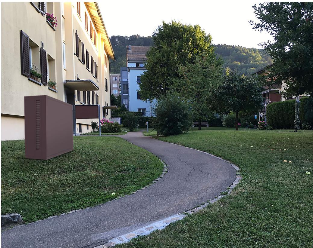
**Abbildung 77: Grosse Luft/Wasser-Wärmepumpe farblich abgestimmt auf Briefkastenanlage.**
