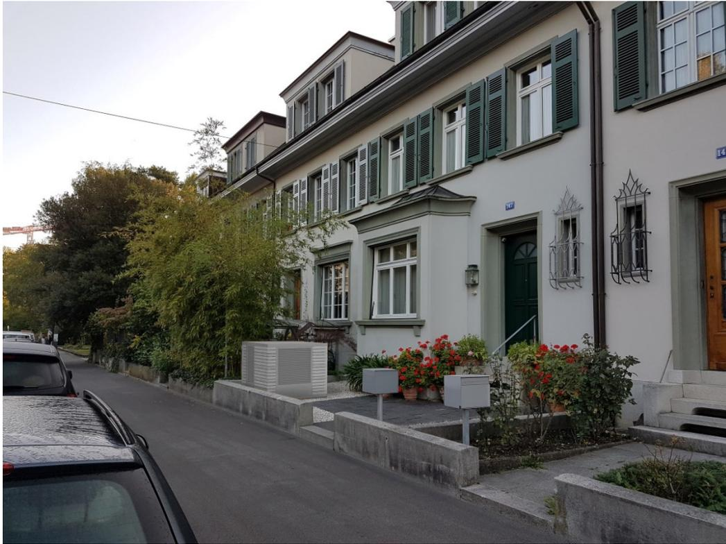
**Abbildung 74: Sichtbare Aufstellung in beengter Vorgartensituation.**
