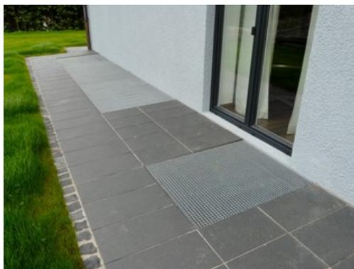
Abbildung 39: Wandgitter und Bodengitter mit Schacht. Quelle: Dimplex
