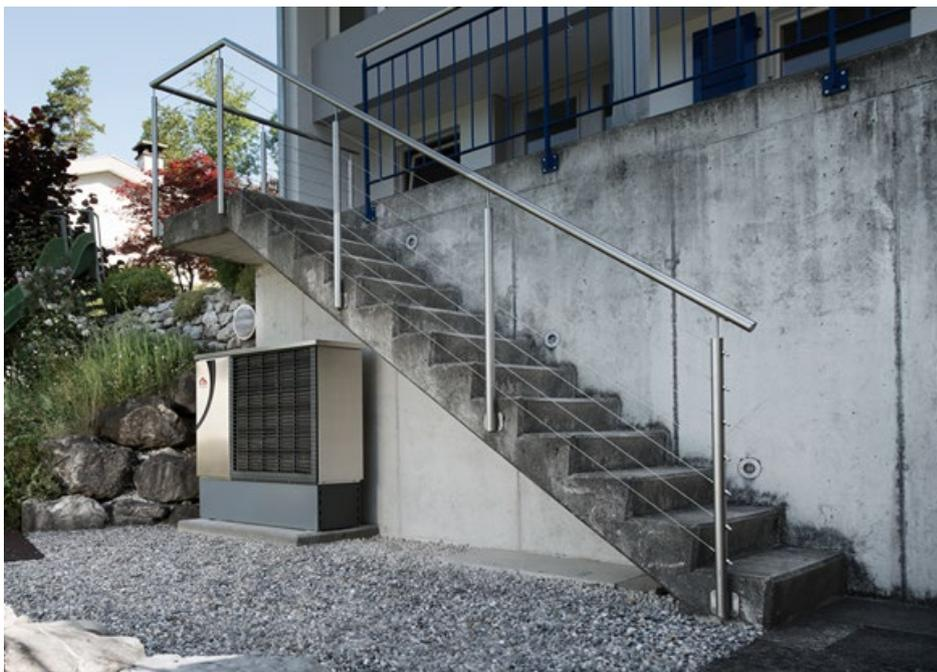
**Abbildung 10: Aussen aufgestellte Luft/Wasser-Kompaktwärmepumpe. Quelle: CTA**
