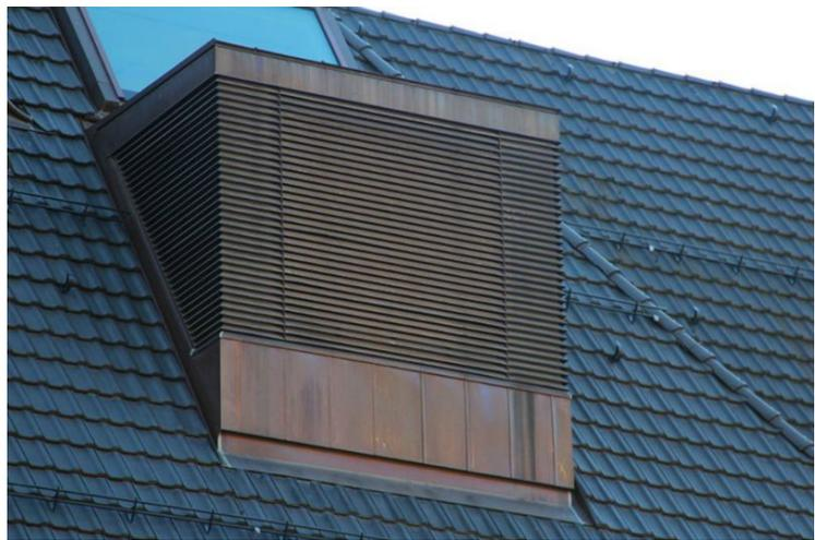
**Abbildung 59: Elemente zur Luftführung für innen aufgestellte Luft/Wasser-Kompaktwärmepumpen im Dachgeschoss (Varianten Luftkamin und Luftlukarne). Quelle: FHNW; Junkers; EM-Blech**
