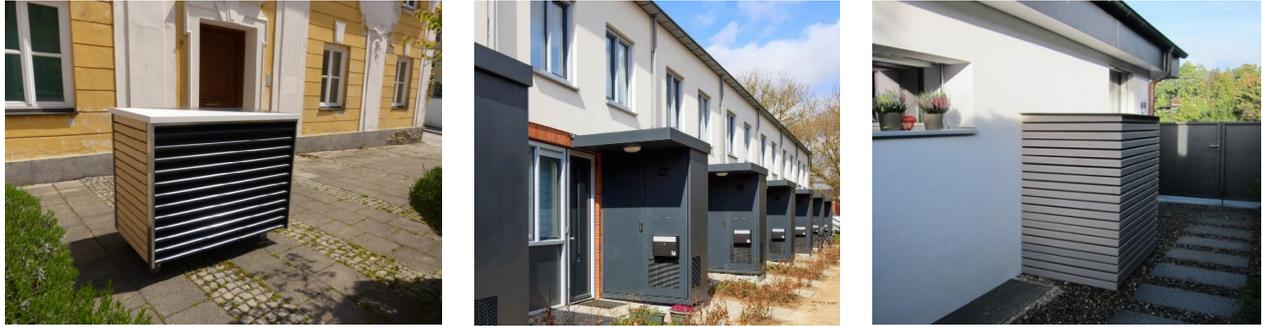
**Abbildung 54: Verbergen durch Verkleidung. Quelle: Wärmepumpen FFB; Nathan AG; Zaugg AG**
