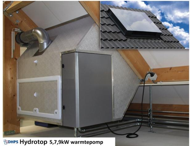
Abbildung 61: Beispiele für die Innenaufstellung im Dachgeschoss. Quelle: Junkers; Dutch Heatpump Systems
