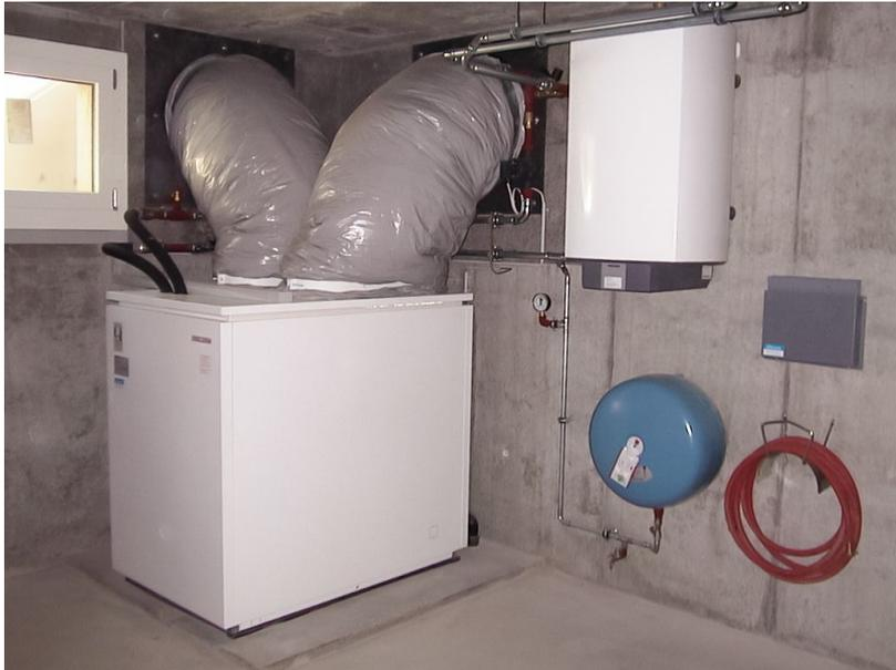
**Abbildung 9: Innen aufgestellte Luft/Wasser-Kompaktwärmepumpe. Quelle: Schwab HSK**
