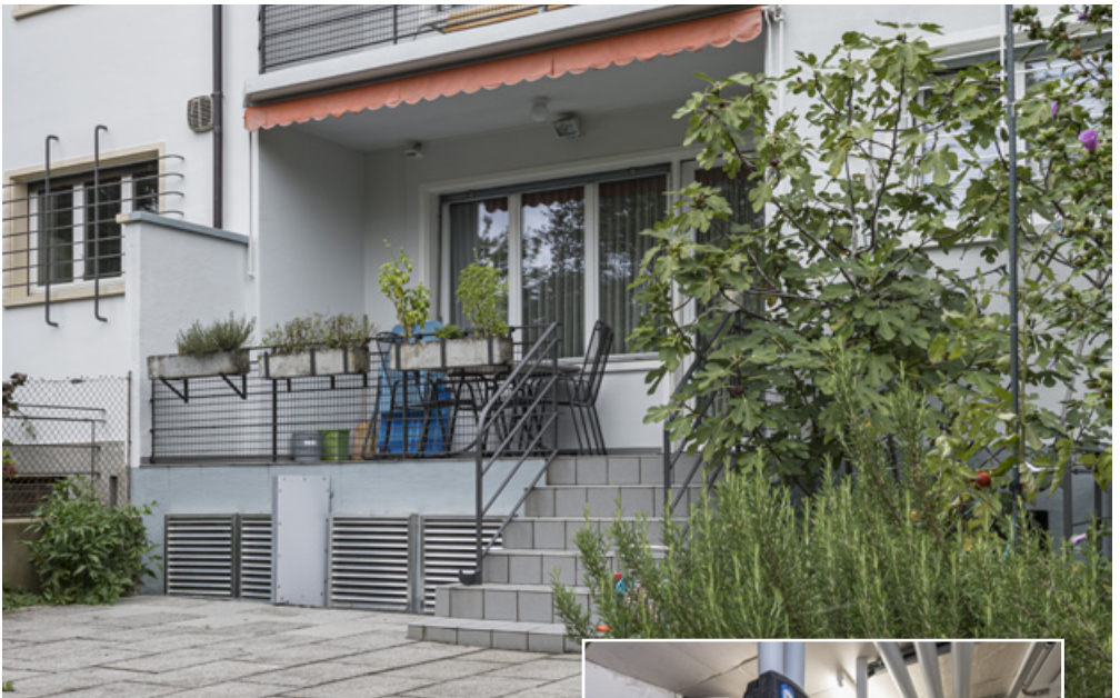
Lufteinlass und -auslass unter der Terrasse, die beiden innen aufgestellten Wärmepumpen im Heizungskeller.
