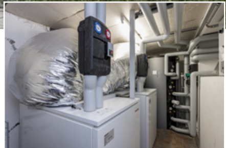
Lufteinlass und -auslass unter der Terrasse, die beiden innen aufgestellten Wärmepumpen im Heizungskeller.
