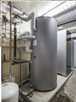
Solaranlage und Wärmepumpe auf dem Flachdach, Kombispeicher und Innenteil der Wärmepumpe im Heizungskeller.
