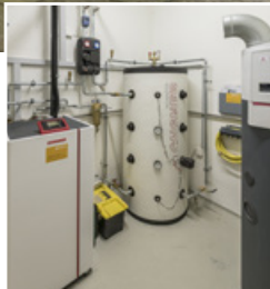
Schwabender Einbau der Ausseneinheit beim Kellereingang, Heizungskeller mit Heizungsspeicher und Wärmepumpenboiler.
