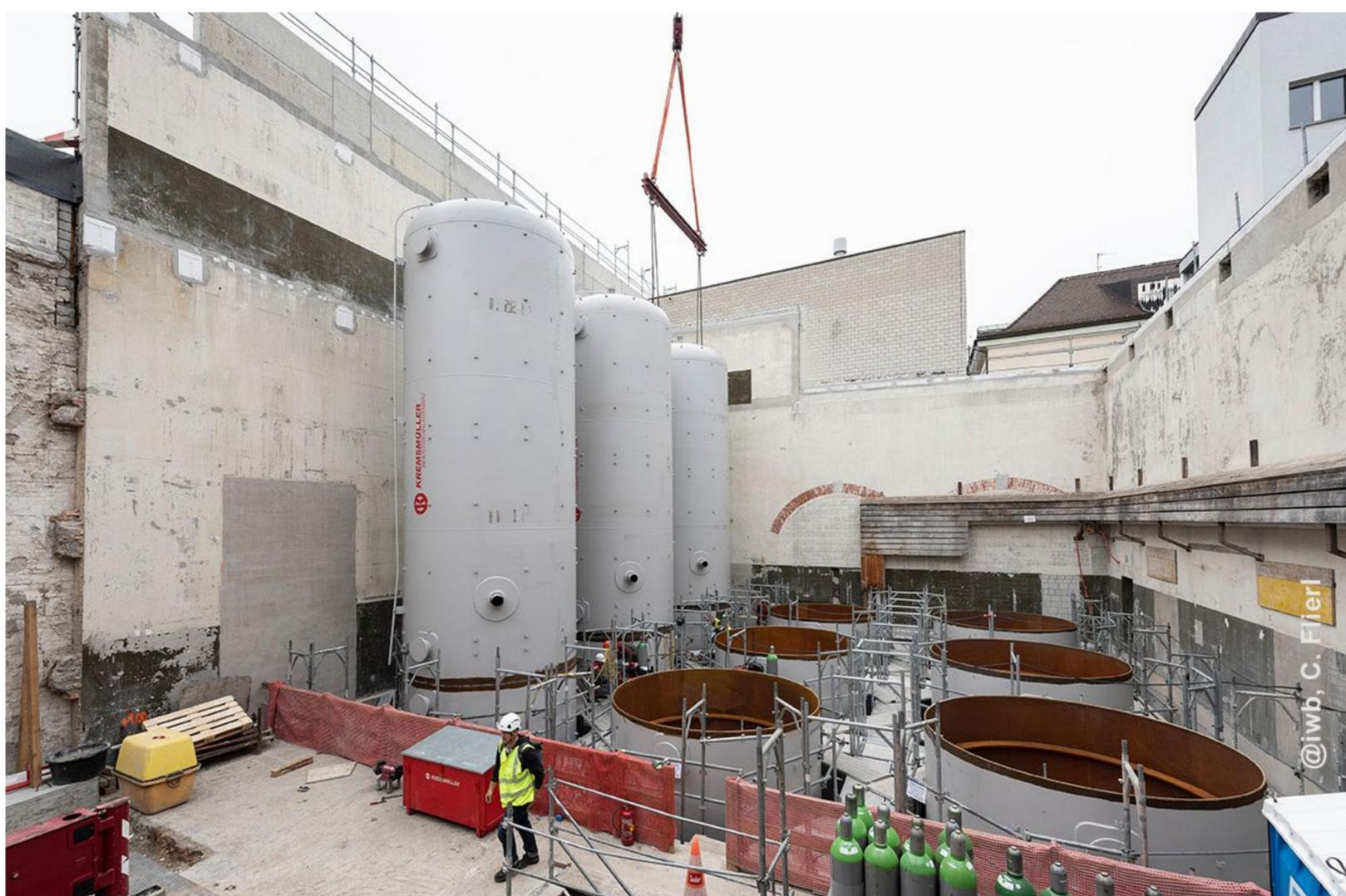
Ici, au Dolderweg, se trouve un accumulateur de chaleur d'une capacité de 1,26 million de litres d'eau. Une photo prise pendant les travaux de construction de l'"accumulateur de chaleur Dolder" montre ses dimensions.
