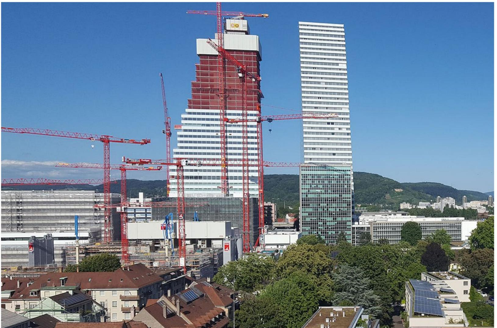
La proportion de fenêtres sur la façade des tours Roche est proportionnellement faible, ce qui est un avantage pour la protection thermique en été.
