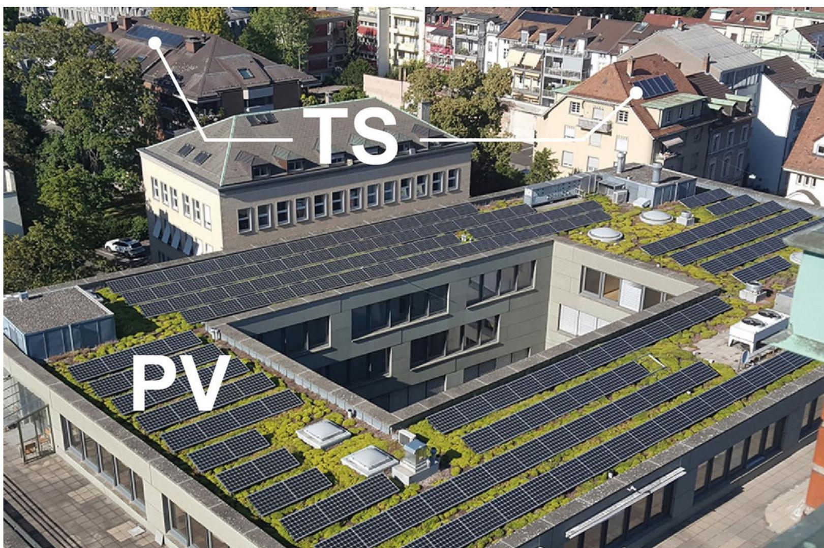
Il existe deux types d'installations solaires : les installations photovoltaïques (PV) utilisent des cellules solaires pour convertir la lumière du soleil en électricité. Une installation solaire thermique (TS) utilise des collecteurs solaires pour produire de l'eau chaude avec la chaleur du soleil.
